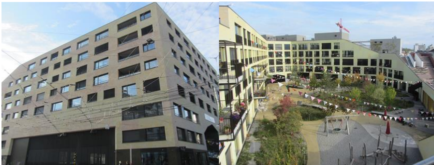
Blick auf Wohnüberbauung Kalkbreite (Architektur: Müller Sigrist, Zürich)
