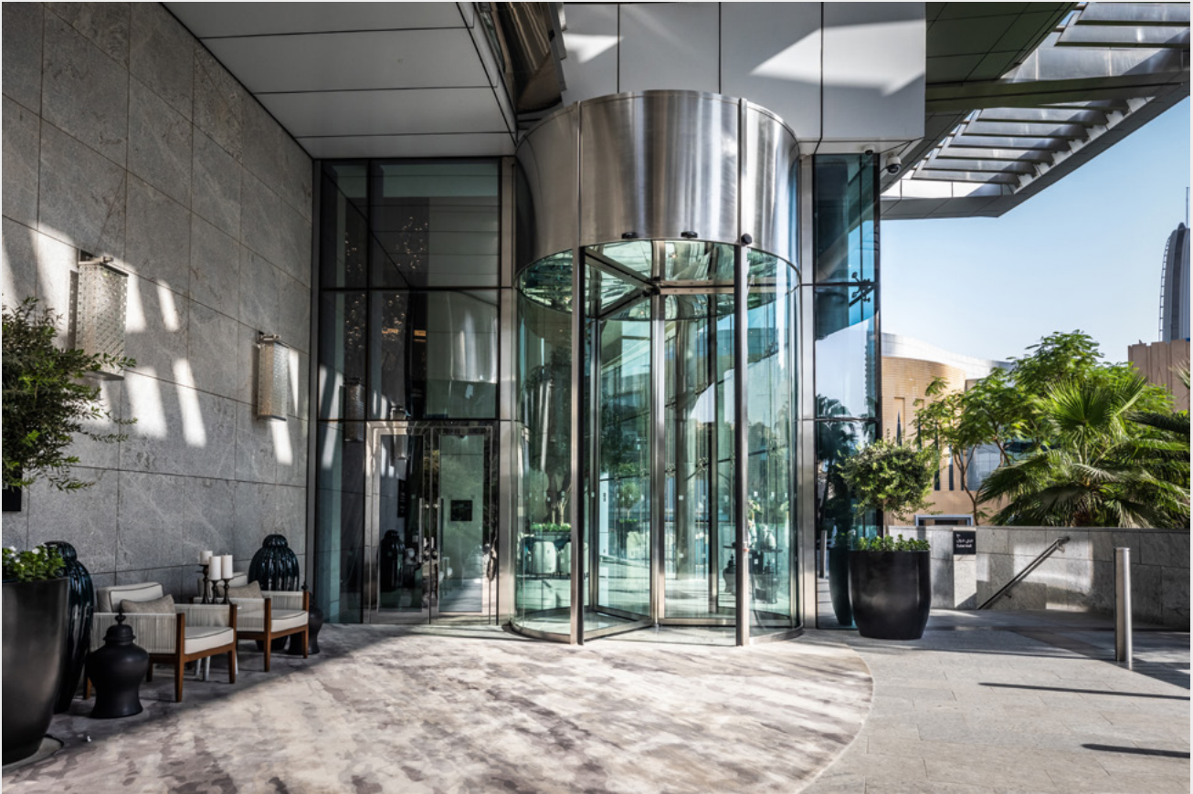
Automatische Karusselltüren von GEZE sorgen für Begehkomfort.
